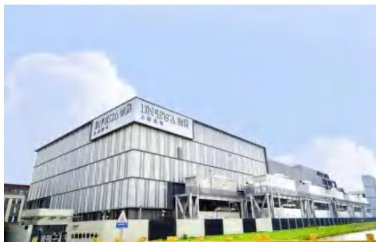
图4：仪电智算中心（松江）一期实景
